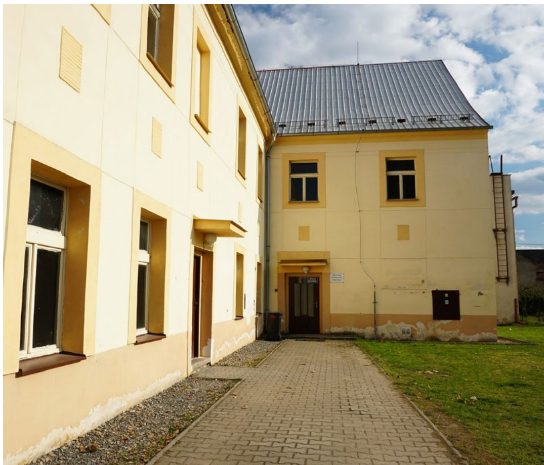
Budova staré školy.
