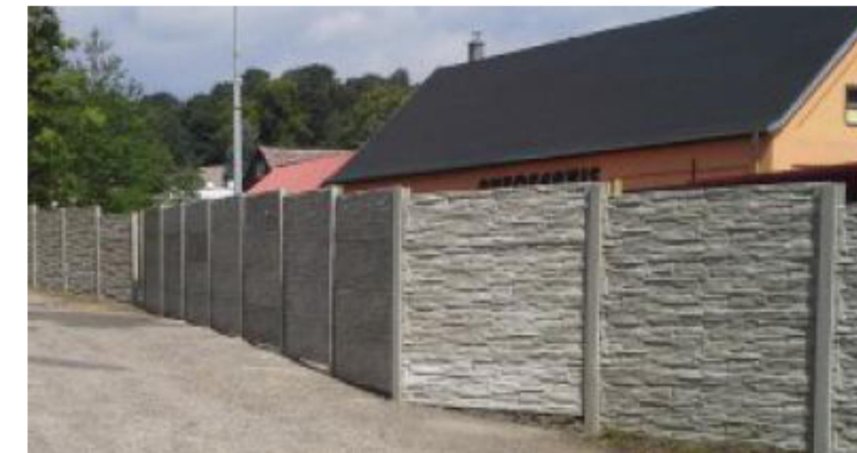
NÁHLED NA NAVRŽENÝ TYP BETONOVÉHO PREFABRIKOVANÉHO OPLOČENÍ - V DANÉM PŘÍPADĚ NAVRŽENÉ PRO AKUSTICKÉ ZLEPŠENÍ VLIVU HRŠTIŠTĚ NA OKOLNÍ PLOCHY BYTOVÉ ZÁSTAVBY
